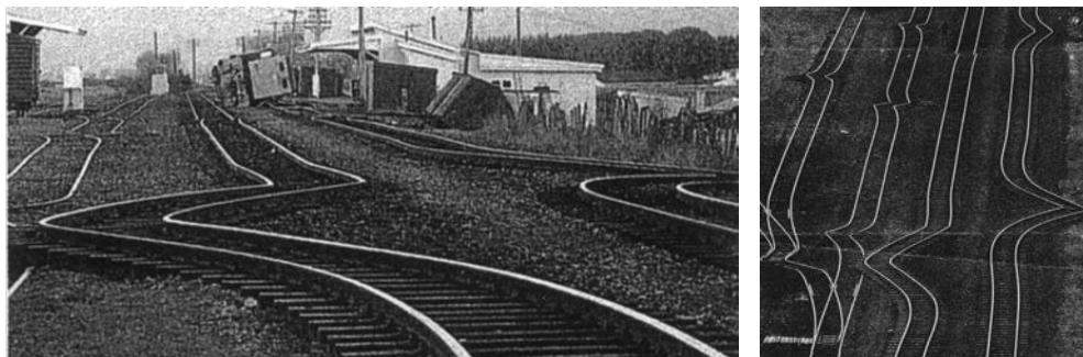
Рис. 81. Восточный залив Пленти (Bay of Plenty) в Новой Зеландии испытал серьезное землетрясение в марте 1987 года. Эти фотографии железнодорожной станции Эджекамб (Edgescumbe) с рельсами, изогнутыми в разные стороны, характеризуют величину сейсмических сил, а также эффекты нелинейностей. Слева — взгляд с уровня земли, справа — взгляд сверху [128].
